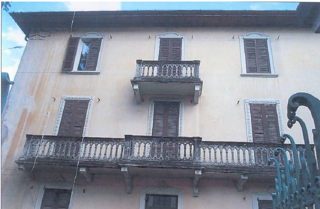
Particolare fronte ovest
